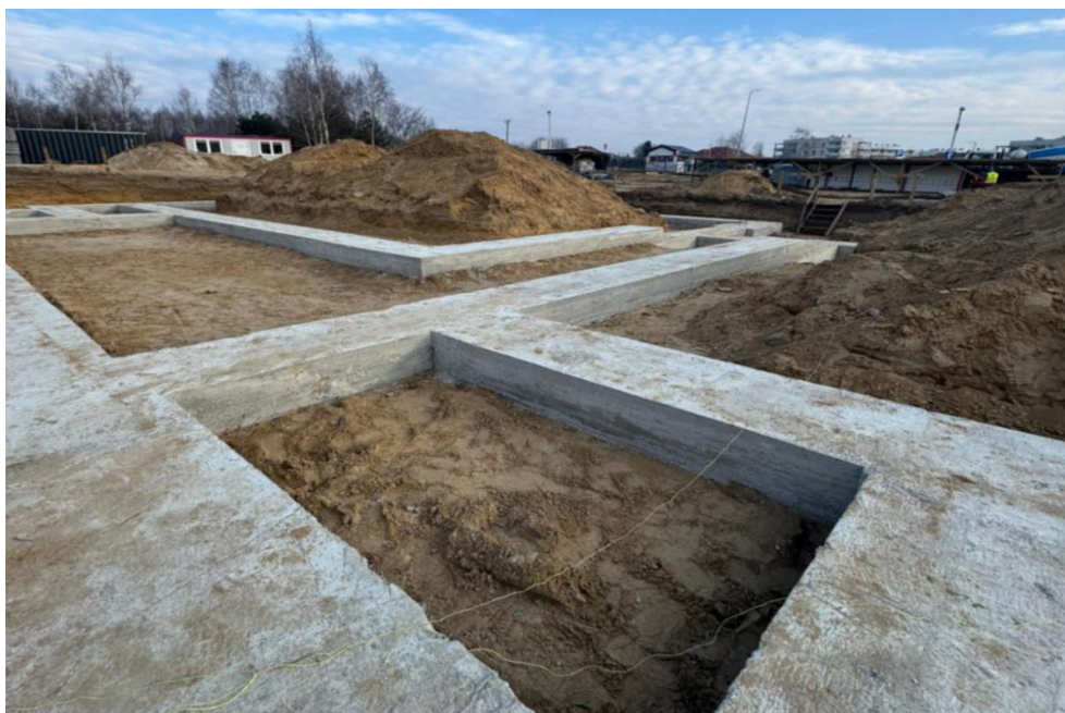
Plac budowy żłobka przy ul. Tatrzańskiej
