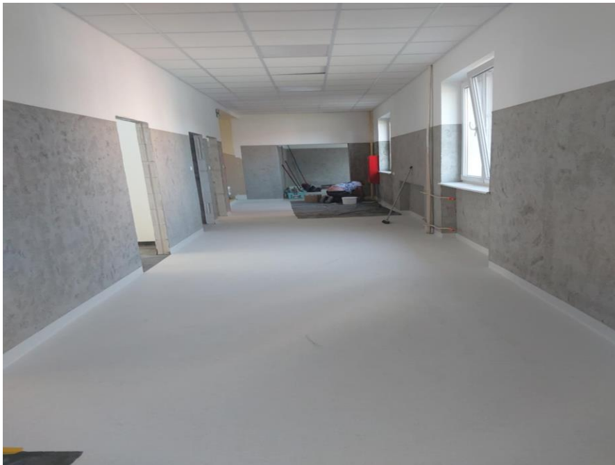
Remont pomieszczeń szkolnych
