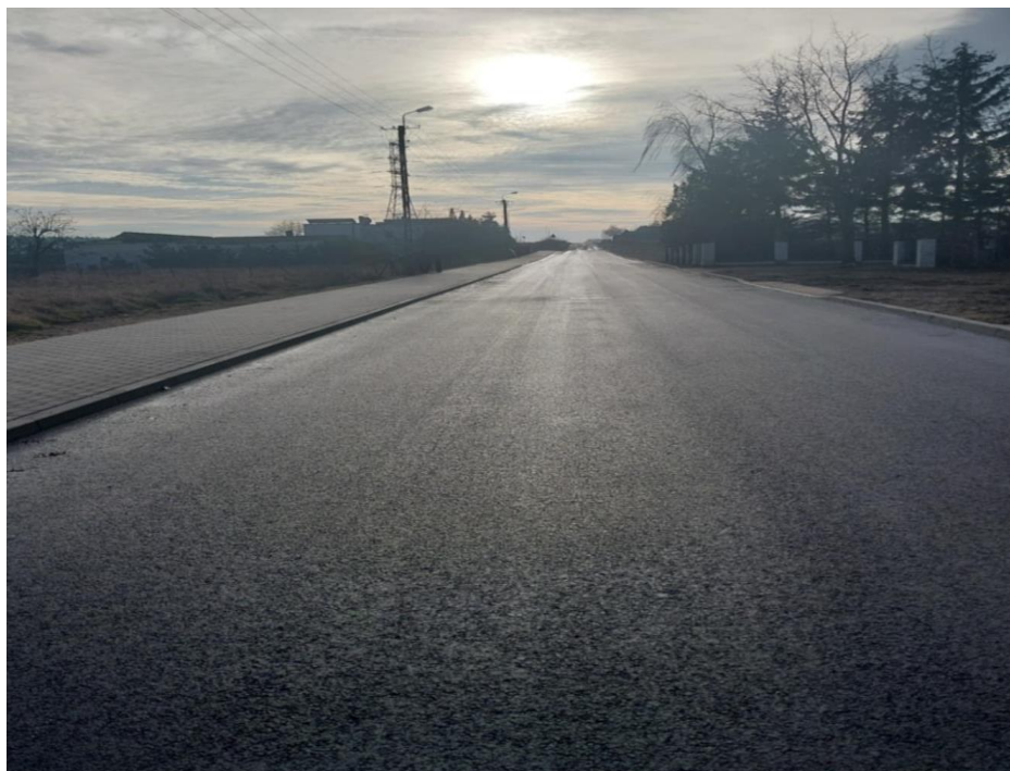
Nowowybudowana ulica Nowa
