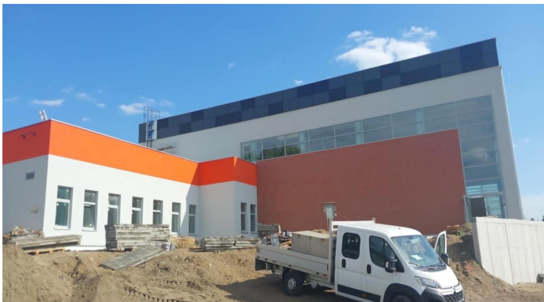
Plac budowy hali sportowej przy Szkole Podstawowej nr 4
