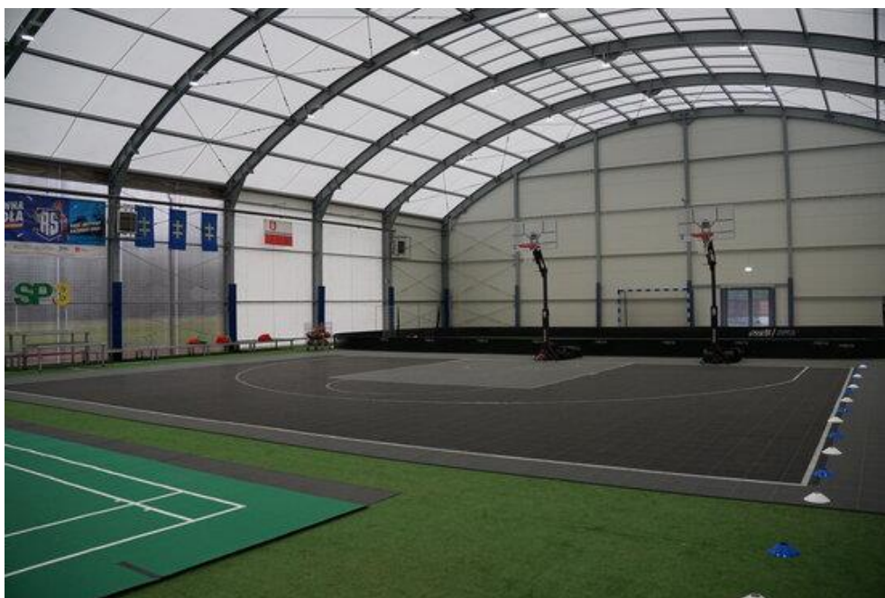
Zadaszenie boiska wielofunkcyjnego przy Szkole Podstawowej nr 3
